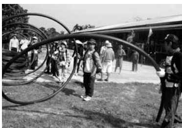
簡易水道のパイプの設置
